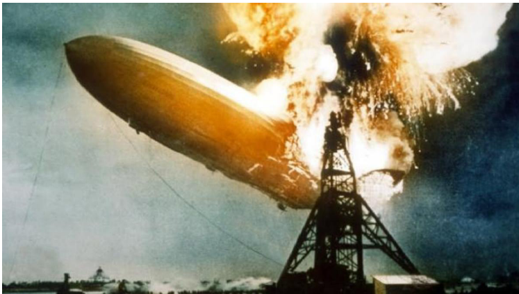
Hindenburg-slysið árið 1937 tafði framþróun í smíði loftskipa um marga áratugi.
