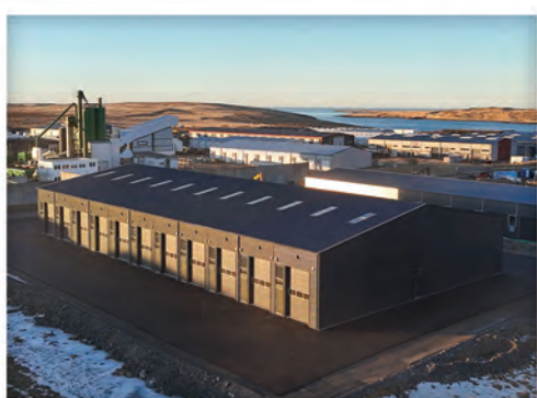
The Hive ehf. - 1.661m 2 - Alverk Járnslettta 2 - Reykjavík - Iðnaðarhúsnæði
