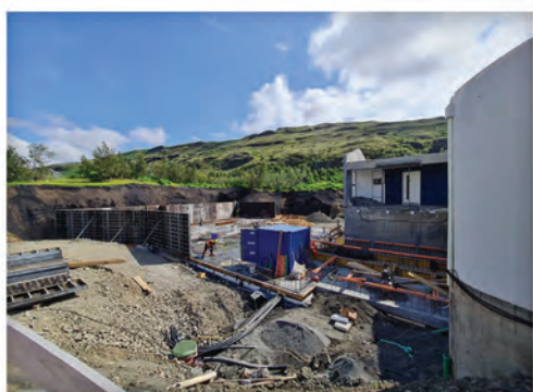
Landsvirkjun - Aðstöðuhús - Alverk Búrfell - Stækkun Eiríksbúðar - "Í vinnslu"
