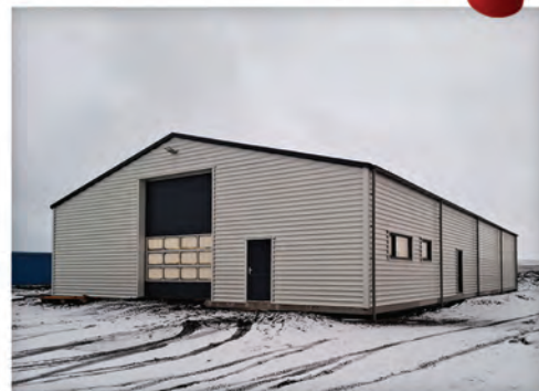
Langanesbyggð - 530m 2 Háholt - Þórshöfn - Sorpflokkunarstöð
