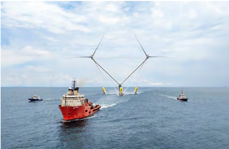
Fyrirhuguð 50 MW tveggja túrbína vindmylla kínverska fyrirtækisins Ming Yang Smart Energy. Minni gerð, 16 MW, er í prófunum í Suður-Kínahafi og hefur reynst vel. Mynd / Ming Yang Smart Energy
