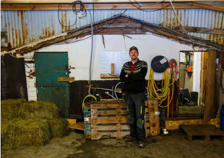
Kristófer stendur við gafl fjárhúsanna þar sem stærðarmunurinn á nýju og gömlu byggingunni sést.
