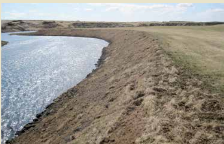
Roðbakki fyrir og eftir gerð bakkavarnar. Meginvörnir er undir yfirborð árinna.
