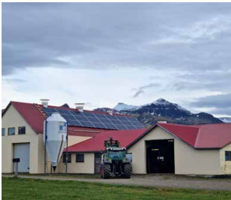
Orkuver á þaki fjóss. Nú stendur yfir rannsókn á virkni sólarsella á Íslandi og var sett upp sólarorkuver á Eystri-Leirargörðum til gagnaöflunar. Mynd / AL
