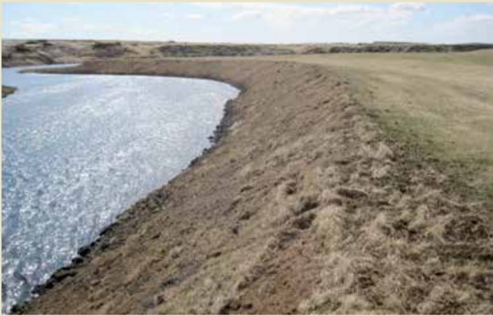
Rofbakkir fyrir og eftir gerð bakkavarnar. Meginvörnir er undir yfirborð árinna.
