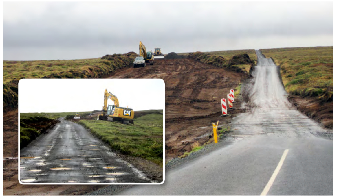
Framkvæmdir við Dettifossveg ganga vel og hafa afköst á svæðinu verið bætt með því að bæta við tækjum og semja við undirverktaka. Myndir / Vegagerðin
