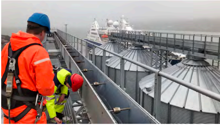
Unnið við fódurverksmiðju Bústólpa.
