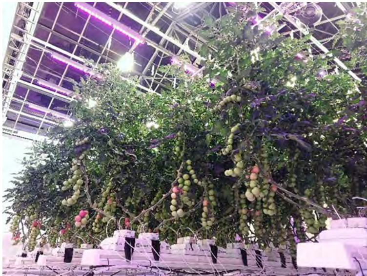
Mynd 2: Hybrid-topplýsing (2:1, HPS:LED; 750 W HPS lampa) hjá tómatalplöntum, lamparnir 4,5 m (HPS og LED) frá gólfi.
