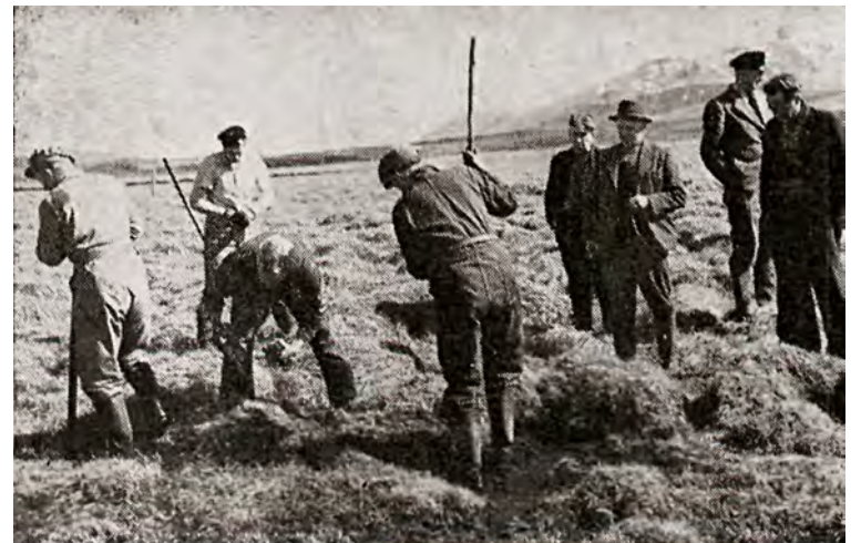
Sprengiefni komið fyrir. Myndin líklega tekin á Hvanneyri á fimmta áratug síðustu aldar.
