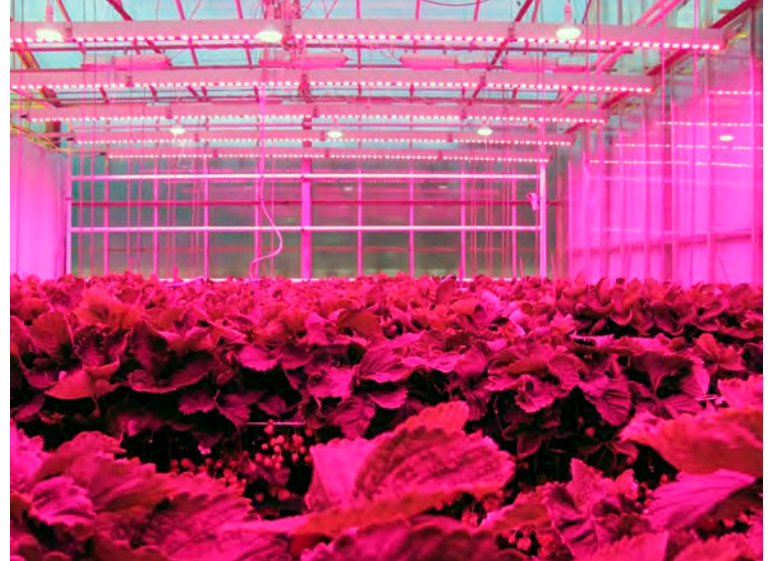
Mynd 1: Jarðarberjaræktun undir LED ljós (Nokkrar LED raðir og sex ljós til vaxtarstýringar sjást á myndinni).
