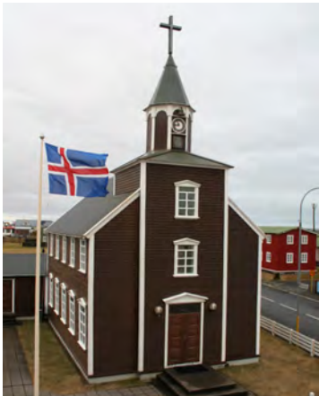
Kirkjan á Eyrbakka, byggð 1890, var friðuð 1. janúar 1990. Mynd / mhh
