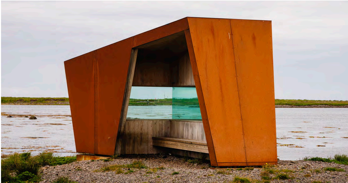
Við Neslón á Melrakkaslétu, skammt norðan við Raufarhöfn, má sjá þetta fuglaskoðunarhús sem hannað er af norsku arkitektastofunni Biotope. Í miðju hússins eru gluggar sem mætast þannig að þeir mynda T séð ofan frá. Vegna þessarar hönnunar er alltaf hægt að vera í skjóli frá vindi án þess að útsynið sé skert.
