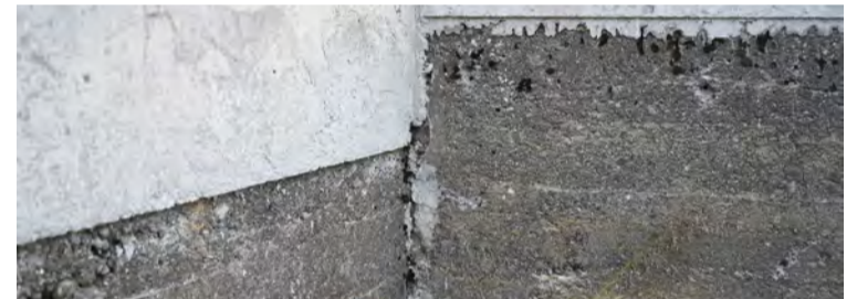
Þegar Tungurétt var gerð upp fyrir áratug voru 100 ára gömlu steypu veggir dílkanna látnir halda sér til að varðveita söguna. Mynd / Jón Bjarki Hjálmarsson
