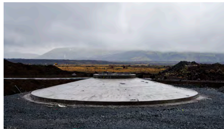
Vindmylluundirstaða sem ekki er búið að hylja með jarðvegi.
