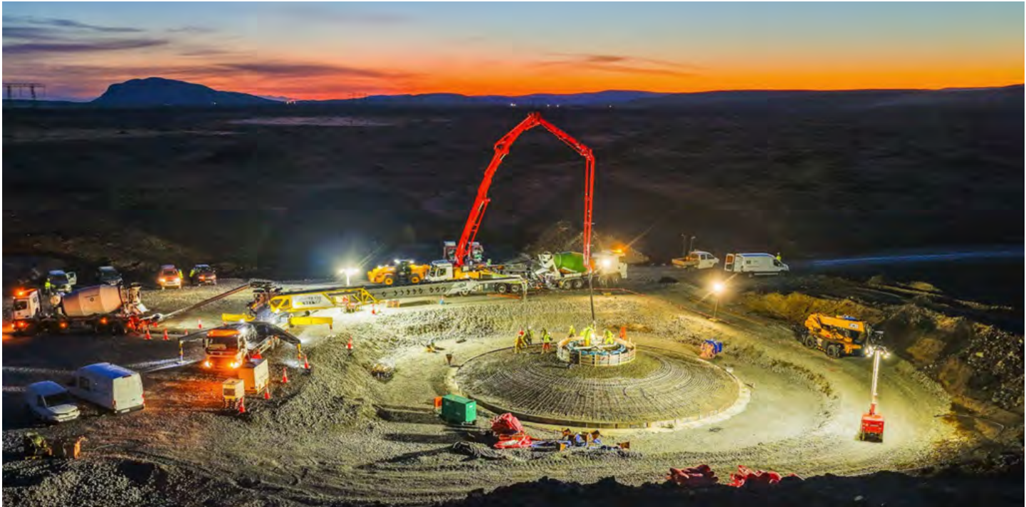
Vaðölduver verður fyrsta íslenska vindorkuverið og er í eigu Landsvirkjunar. Síðla septembermánaðar 2025 steypiti Ístak fyrstu undirstöðu af alls 28 sem reistar verða á svæðinu. Mynd / Landsvirkjun
