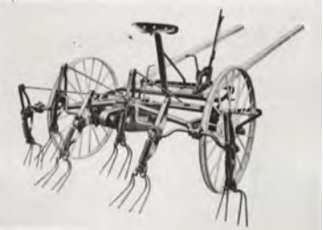
Fyrsta verkfærið til þess að snúa heyi mun hafa komið til landsins árið 1907, líklega frá Arvika Verken í Svíþjóð. Gafflavél mátti kalla hana því með göfflum þeytti hún heyinu upp og aftur undan sér líkt og hæna að störfum á haug. (Búvélar og ræktun).
