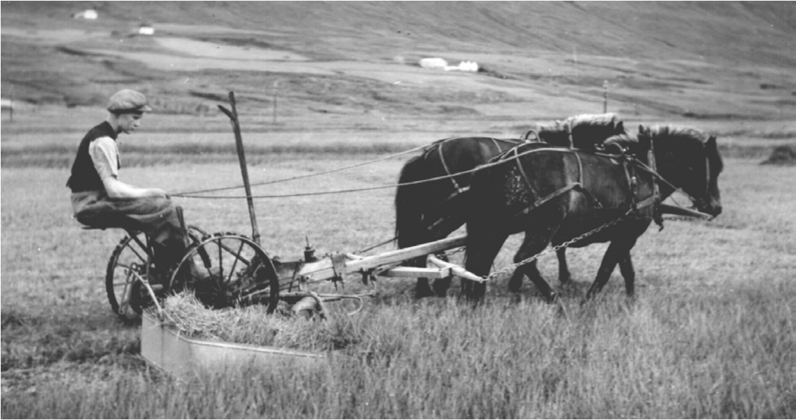
Hestasláttuvélar voru víða helsta heyskaparnýmælið á fyrra helmingi síðustu aldar. Hestknúin verkfæri til sláttar – með greiðu og ljá – bárust svo þúsundum skipti til landsins. Árni Sigurgeirsson á Eyrarlandi slær og notar heyskúffu við engjasláttinn. (Véls. Steindórs).
