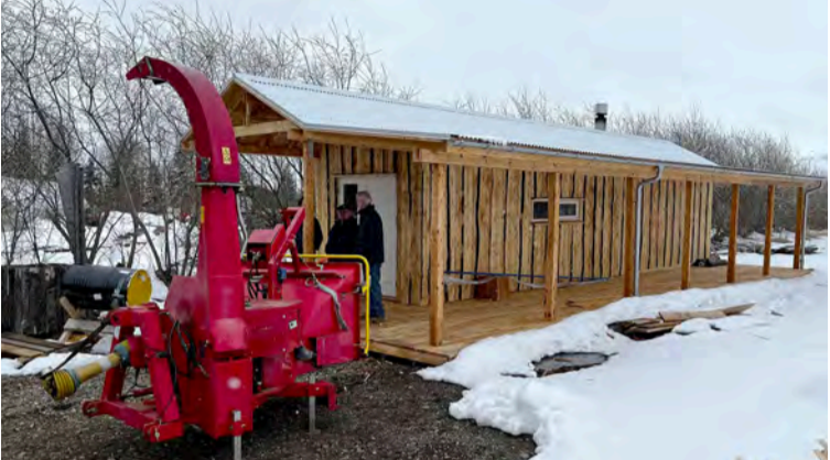
Kyndiaðstaðan í Vallanesi er klædd viði sem fengin er úr skóginum þar. Fyrir framan húsið stendur danskur TP kurlari.
