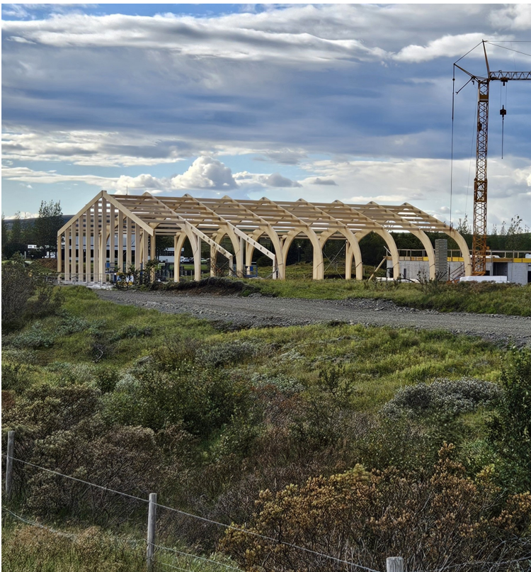
Búið er að reisa burðargrind nýs íþróttahúss í Árnesi og segir oddviti vonir bundnar við að taka megi húsið í notkun fyrir næsta skólaár, 2026, eða jafnvel fyrr miðað við hversu vel framkvæmdir ganga. Mynd / J.Demarthon
