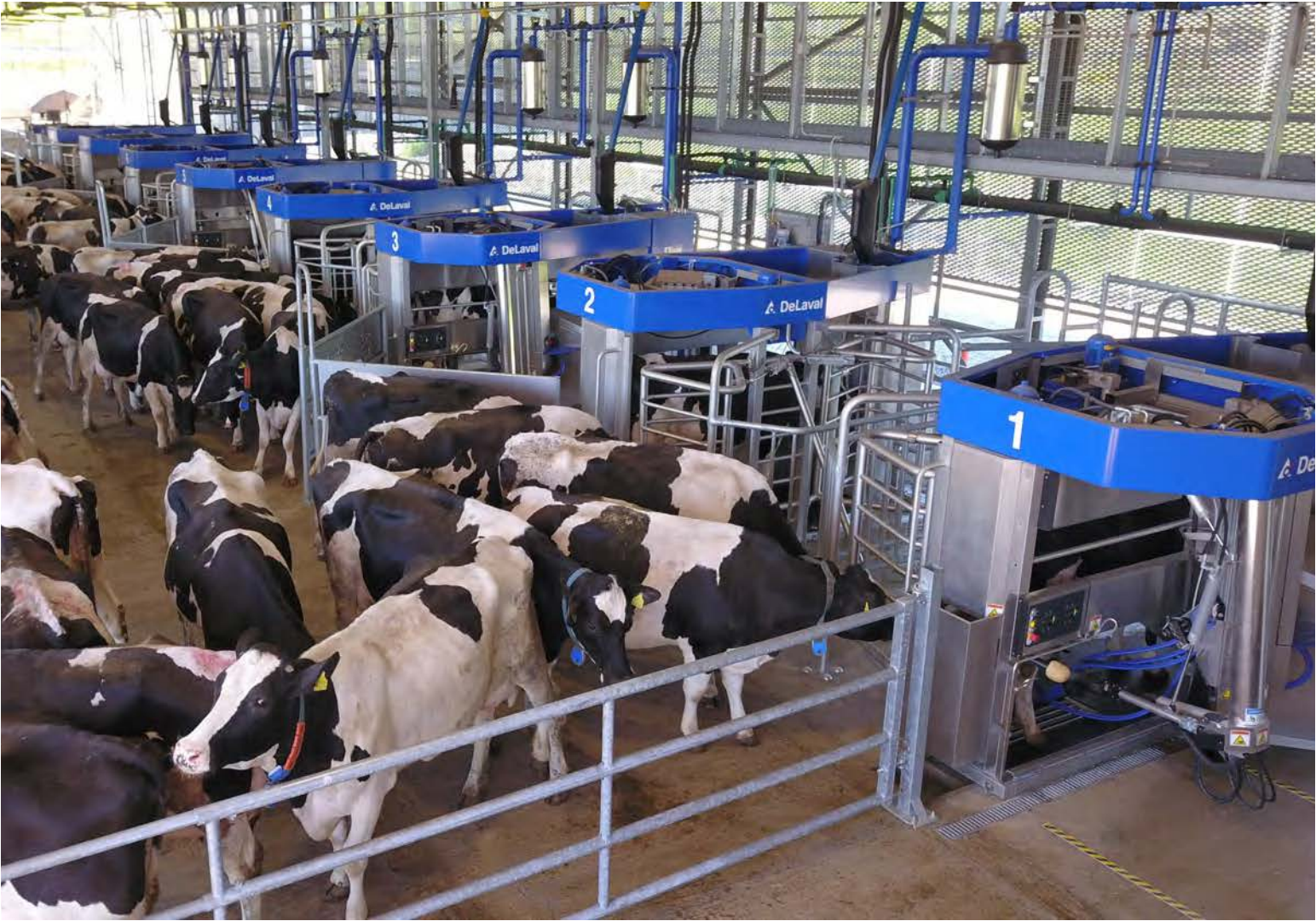
Dæmi frá sænska fyrirtækinu DeLaval þar sem lotumjaltakerfi hefur verið sett upp með 8 mjaltastöðvum.
