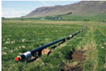
Byrjað var að leggja hitaveitulagnir í Kjósinni 2016 og voru rör fyrir ljósleiðara lögð samhliða.
