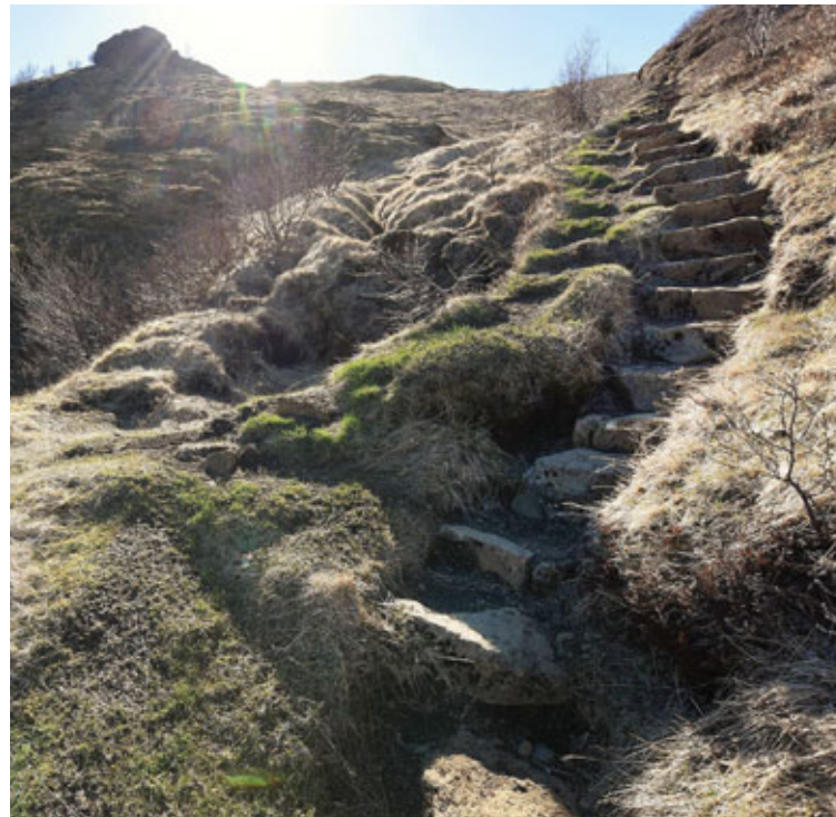
Í Valahnúk í Þórsmörk er að finna dæmi um vel hannaðan göngustíg sem virðist endast vel. Stígurinn var gerður fyrir fáeinum árum, unnið var með náttúrunni, notast var við staðbundinn efnivið og kapp lagt á að hann félli vel að umhverfinu.
