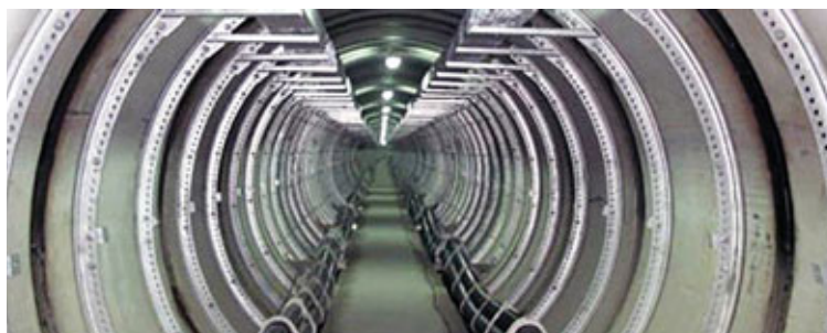
Í Sjanghai í Kína var lagður 500 kílóvolta og 17 km XPLE strengur í sérstökum lagnagöngum. Hann er sagður fyrsti og lengsti innanborgarstrengurinn af þessari stærð og var lagður vegna heimssýningarinnar í Sjanghai 2010.
