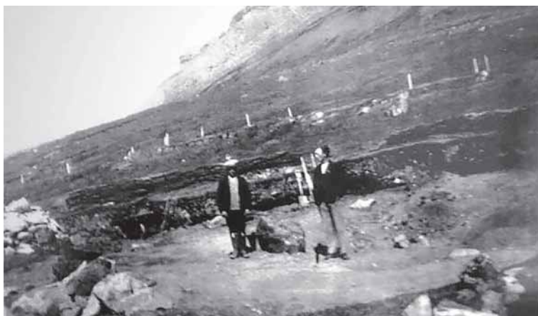
Bygging „nýja“ skólahússins hófst sumarið 1931. Hér er gróftur grunnsins langt kominn.
