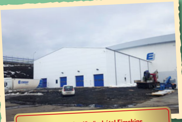
Kæligeymsla við vöruhotel Eimskips við Klettagarða í Reykjavík
