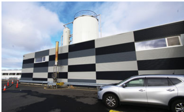
Stærsti tankur hreinsistöðvarinnar stendur upp úr þakinu. Utan á veggnum má sjá gasbrennarann sem notaður er til að eyða með bruna umframbirgðum af metangasi sem verður til við vatnshreinsunina.
