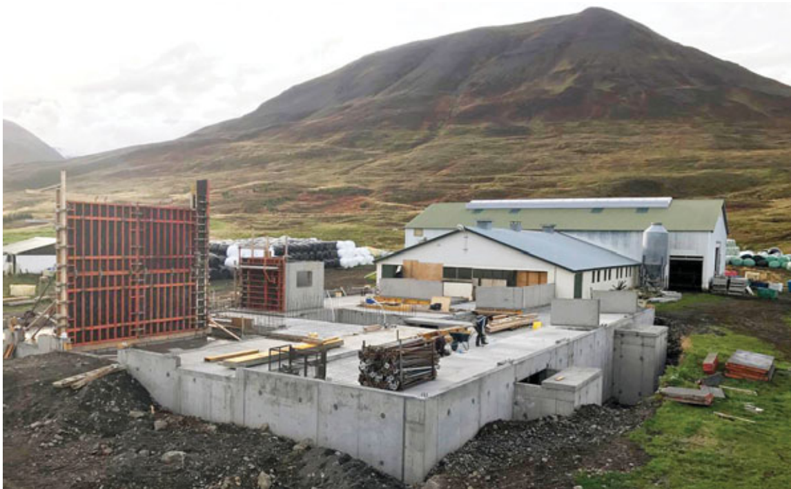
Lokið hefur verið við að steypa upp kjallara viðbyggingar við fjósið á Hóli á Upsaströnd. Starfsmenn Landstólpa munu svo reisa bygginguna í byrjun nóvember.
