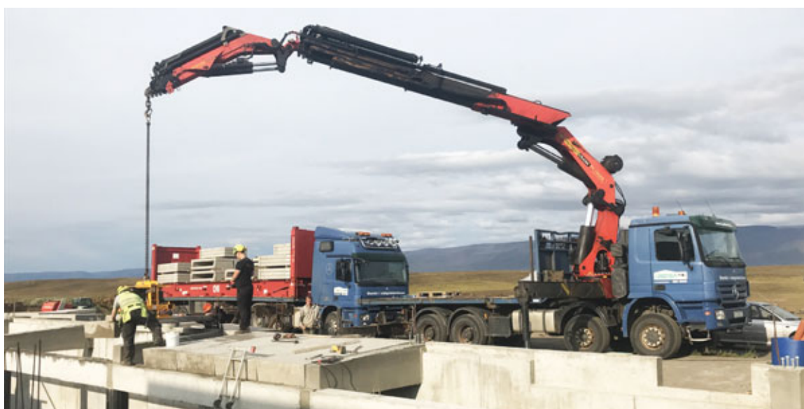
Eitt af Landstólpafjósum sem unnið verður við að reisa á næstu mánuðum norðan heiða er á Sólheimum í Skagafirði. Fyrirtækið fjárfesti í sérstökum sogskálakrana sem getur hift 2 tonna steypueiningar í einu.
