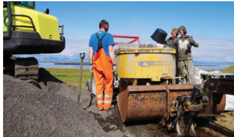
Steypa hrærð í dráttarvélardrifinni steypuhrævíl.
