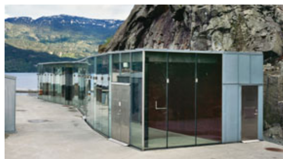
Þjónustumiðstöð við ferjubryggju í Ropeid í Ryfylke. Arkitektar: Jensen & Skodvin. Mynd / Vegar Moen/Statens vegvesen.
