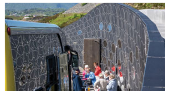
Áningarstaðurinn Eldhusøya þar sem er kaffi- og salernisaðstaða. Arkitektar: Ghilardi + Hellsten arkitekter AS, landslagsarkitekt: Asplan Viak AS. Mynd / Jarle Wæhler/Statens vegvesen.
