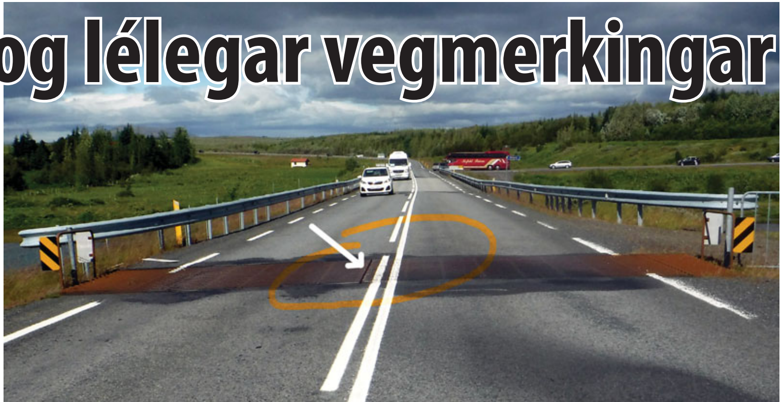
Þar sem áður var ætlað gangandi er nú ómerkt og deila því báðar akreinar allri brúnni og grindarhliðinu sem gerir þessa rifu sem reiðhjól geta farið niður um.
