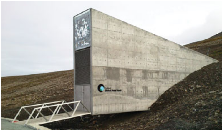
Inngangurinn að frægeymslunni á Svalbarða.
