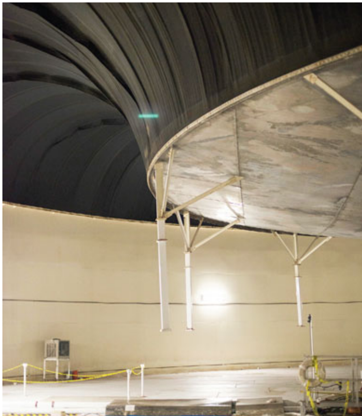
Eitt af tveimur „Lungum“ Biosphere 2, 20.000 kg hvert, jafna út loftþrýstingnum, sem gæti annars sprengt gler hjúpsins.
