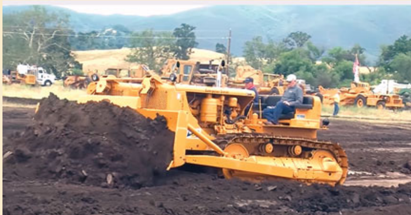
Uppgerð Caterpillar Twin D8 í jarðvegsvinnu.
