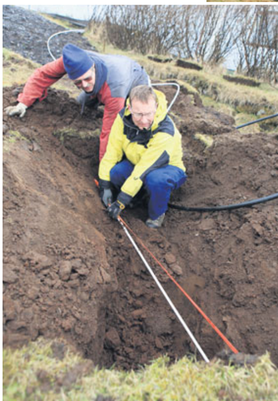
Ólafur Stígsson bóndi, Steig, og Ingólfur, Brún, við lagningu ljósleiðarans í fyrravor.
