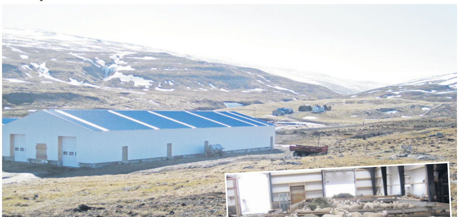
Tröllatunga í Strandabyggð. Nýju fjárhúsin næst sambyggð eldri húsum á jörðinni.
