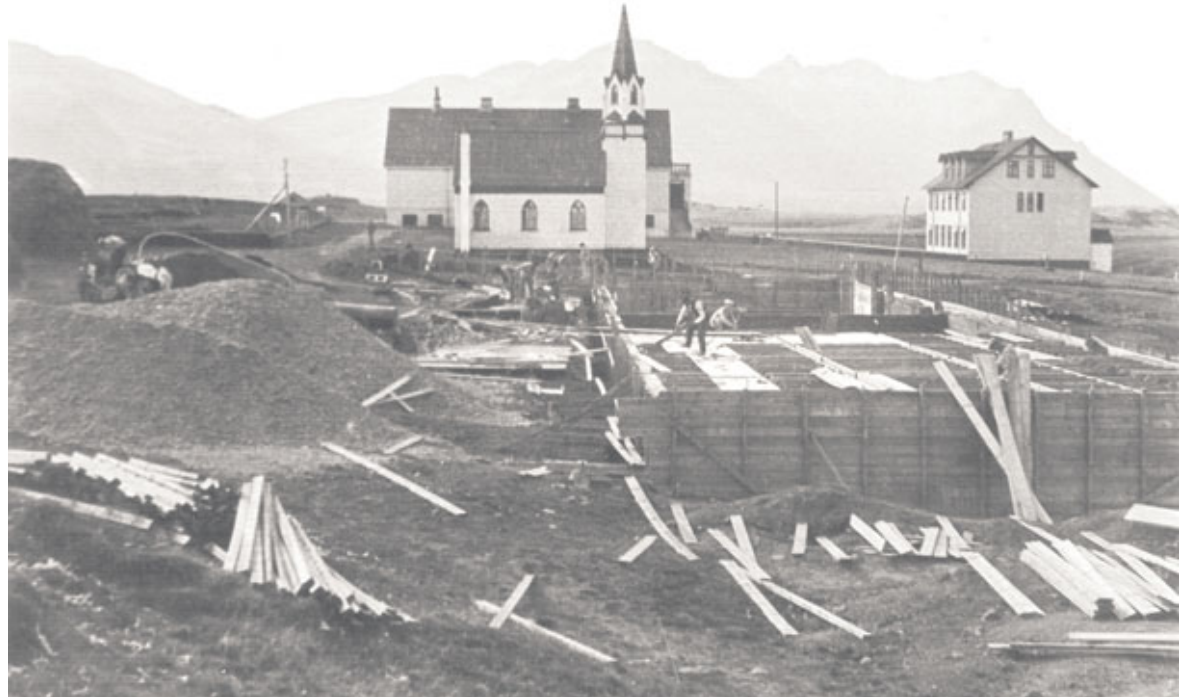
Unnið að byggingu áburðarkjallara Halldórsfjöss sumarið 1928.
