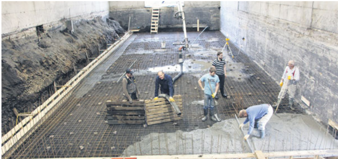
Unnið að steypu á botnplötu. Tæplega 3 metra djúpt haughús er undir legubásasvæðinu en fleytiflórar við gjafasvæðið.
