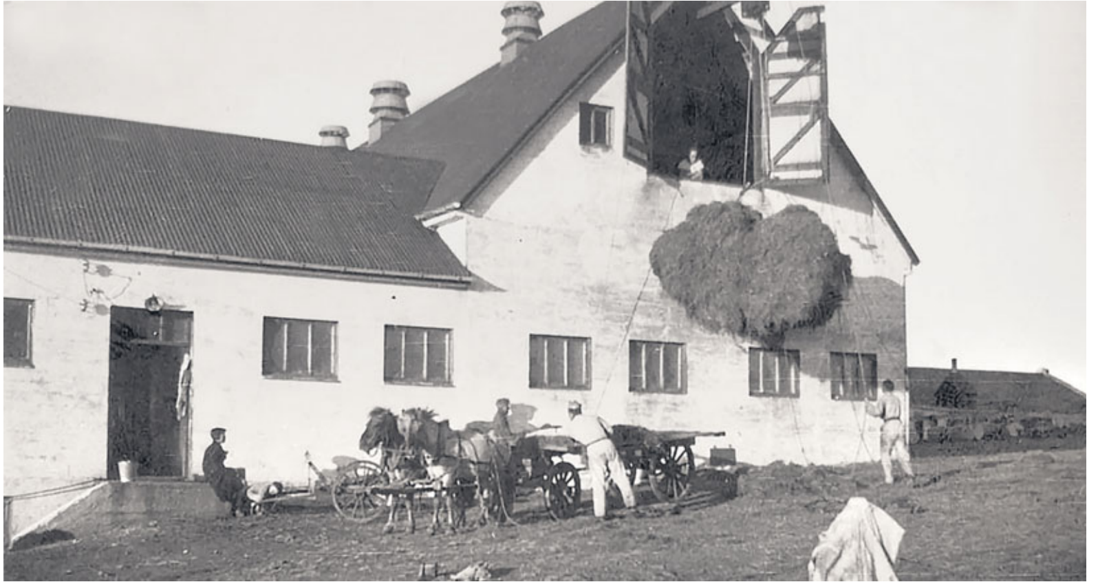
Hirt í hlöðu Halldórsfjöss sumarið 1938. Þá var enn tími fjórhjóra vagna og dráttarhesta; með vindu voru heyllössin undin upp og inn í hlöðu.
