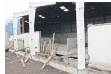
Til að uppfylla burðarþólið voru settir sterkir bitar neðan í gömlu sperrurnar svo engar stoðir eru undir þakinu.
