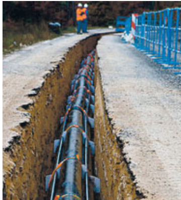
Frá lagningu jarðstrengja í Frakklandi.
