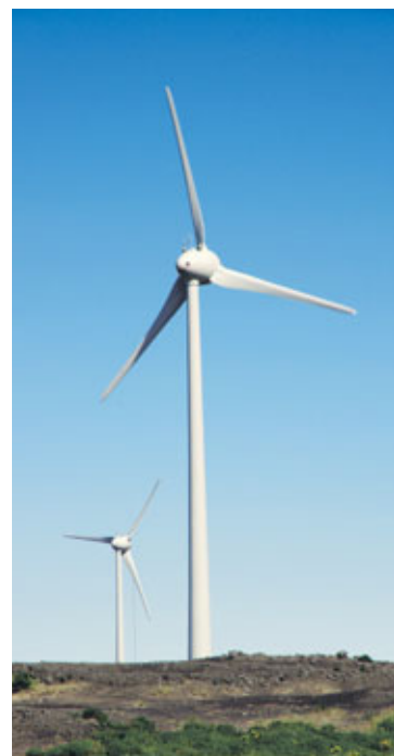
Vindmyllur Landsvirkjunar á Hafinu ofan við Búrfell.
