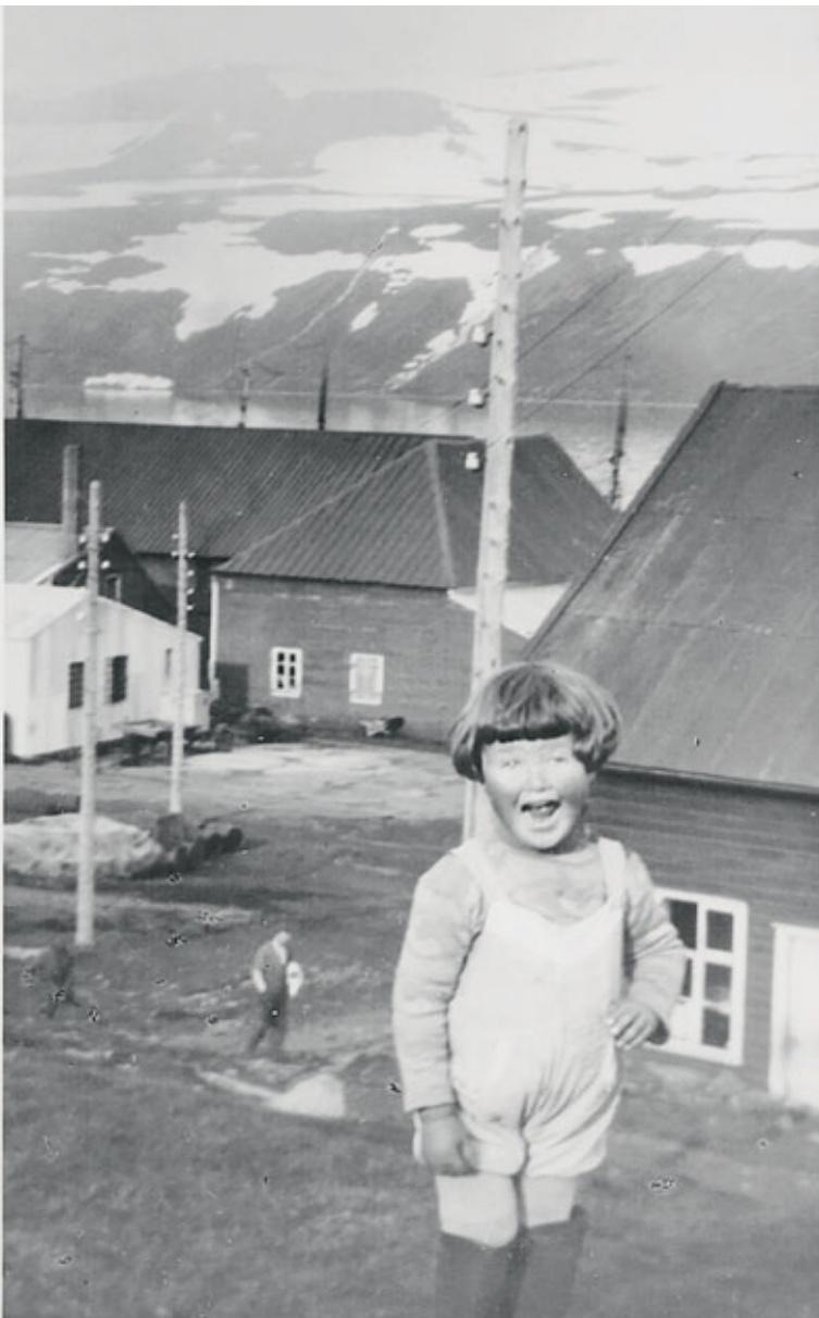
Sildarverksmiðjan Hekla í Hesteyrarfirði var ekki sett í gang eftir 1941. Sildin færði sig austur með Norðurlandi og stöðin orðin gömul og óhagkvæm. Kveldúlfur kvaddi staðinn og atvinnulífið stóð bágborið eftir.
