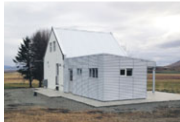
Unnið hefur verið að endurbótum á íbúðarhúsinu í Búlandi og er þeim nú að mestu lokið.
