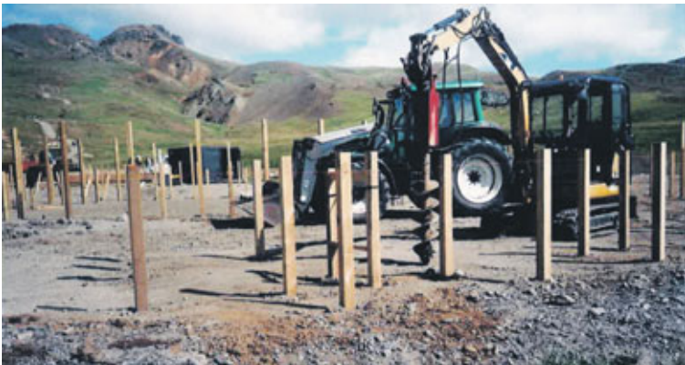
Vandað var til verka við frágang jarðvegs undir réttina. Var sérstakur staubor notaður til að grafa holurnar fyrir staurana í gegnum þjappað malarlag.
