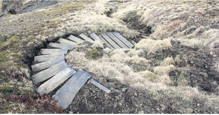
Hér voru tröppur felldar inn í niðurgraffinn stíg. Lítið sem ekkert þurfti að raska gróðri til viðbótar við það sem þegar hafði orðið.
