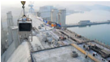
Danjiangkou-stíflan í Kína í byggingu. Mynd / Imaginechina
