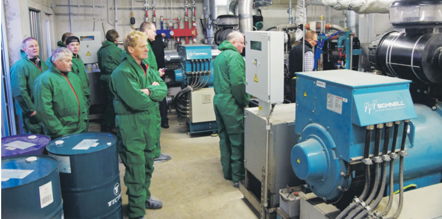
Metangasið sem framleitt er á bænum er notað til að keyra rafstöð sem framleiðir 500 kílóvött sem selt er inn á raforkukerfi héraðsins.
