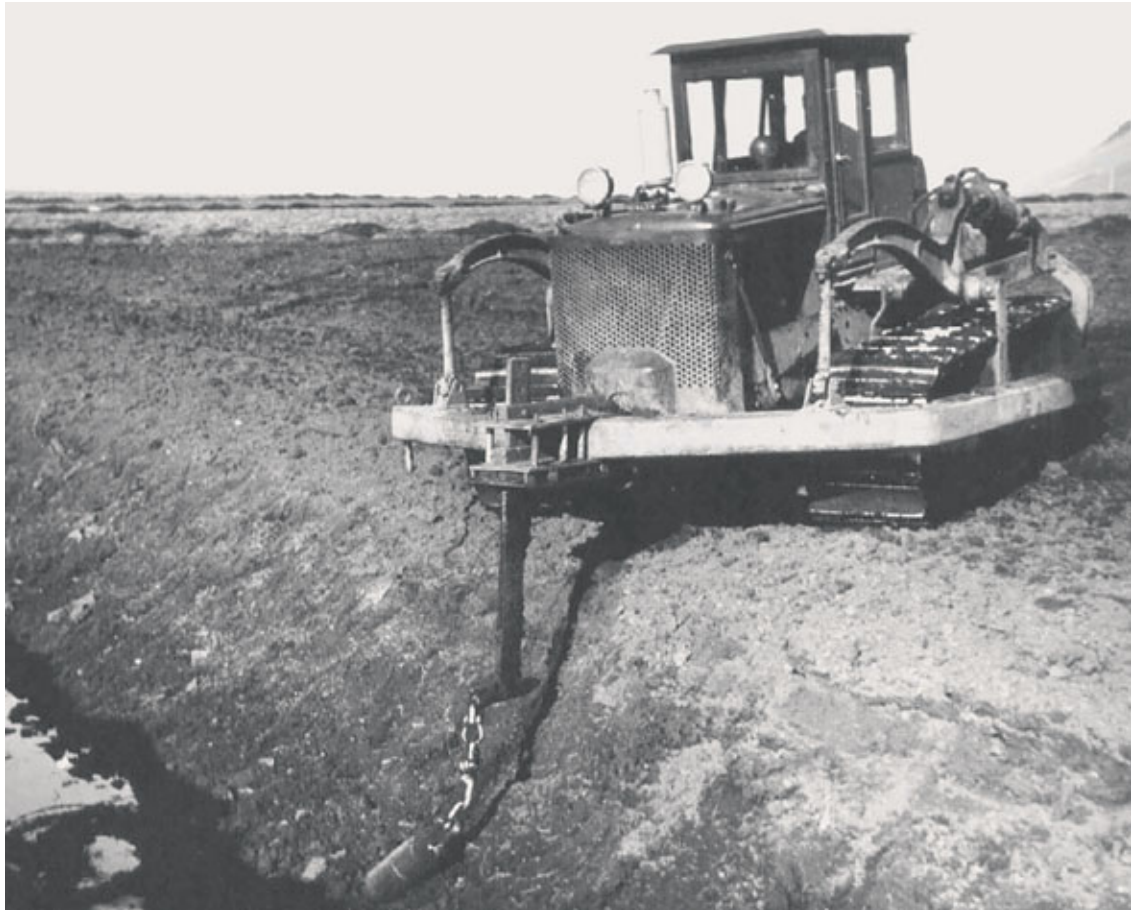
Kilplógur á beltavél; hugmynd Þorsteins Stefánssonar á Ósi í Skilmannahreppi. Með plógnum voru gerð kílræsi svo spara mætti opna skurði við þurrkun ræktunarlanda.
