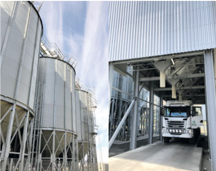
Við verksmiðju Bústólpa á Oddeyri á Akureyri hafa nú risið 8 ný hráefnissíló, sem rúma alls 2.700 tonn af korni til fóðurframleiðslu og einnig 10 síló fyrir fullunnið fóður.
