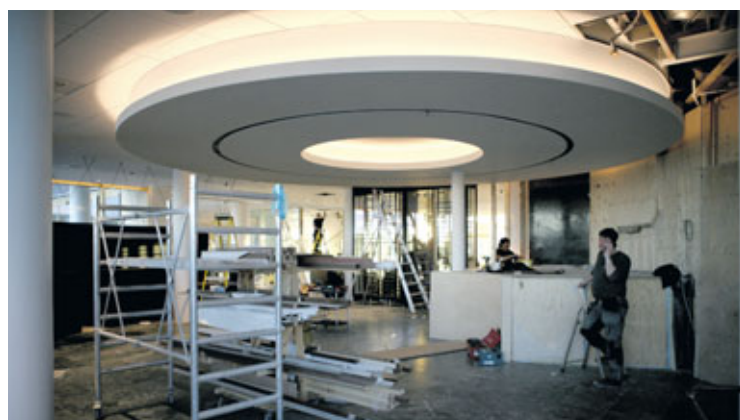
Framkvæmdir komnar á lokasnúning.
