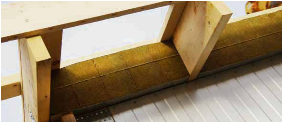
Hér sést vel hvernig þak og veggir mætast. Lásar milli þakeininganna eru jafnframt nýttir eins og hefðbundnar sperrur til að bera uppi þakkant.
