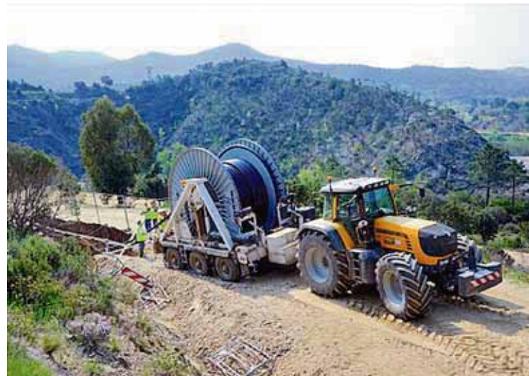
Jarðstrengur dreginn í plaströr sem steipt hafa verið í 80 cm breiðan og 130 cm djúpan skurð í fjallendi í Suðaustur-Frakklandi. Mynd /RTE
