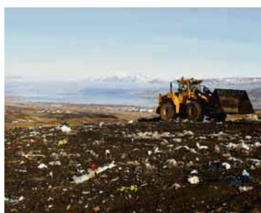
Sorphaugarnir á Glerárdal. Sjálfsafgreiðslustöð fyrir metan verður byggð við Miðhúsabraut á Akureyri.
