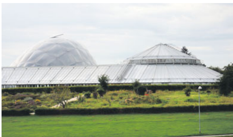
Fyrsta gróðurhúsið í grasagarðinum var upphaflega reist árið 1970 en byggt við það 2011 og aftur 2014.
