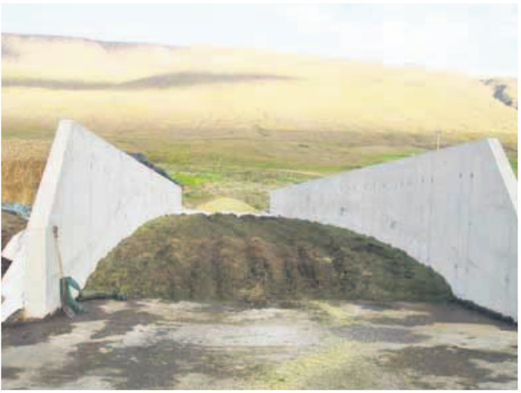
Flatgryfjur voru teknar í notkun á Hríshóli árið 2011, en þær eru 2,70 á hæð, 6,5 metrar á breidd og um 35 metra langar. Sigurgeir er þess fullviss að heyskaparaðferð af þessu tagi muni ryðja sér til rúms á komandi árum.
