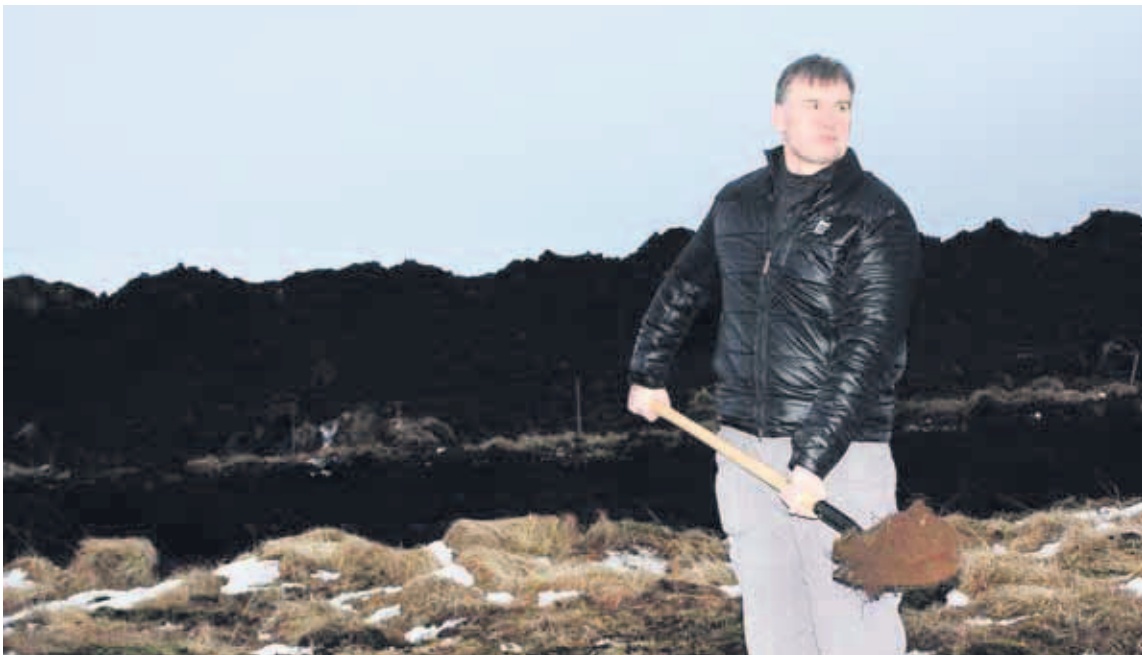
Bjarni Stefánsson, loðdýrabóndi í Túni í Flóa, var stoltur og ánægður eftir að hafa tekið fyrstu skóflustunguna að nýrri byggingu Fódurstöðvar Suðurlands. Myndir / MHH
