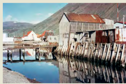
Bólverkið á fremsta hluta Dokkunnar skömmu áður en það hvarf undir uppfyllingar vegna framkvæmda við nýja Sundahöfn.
