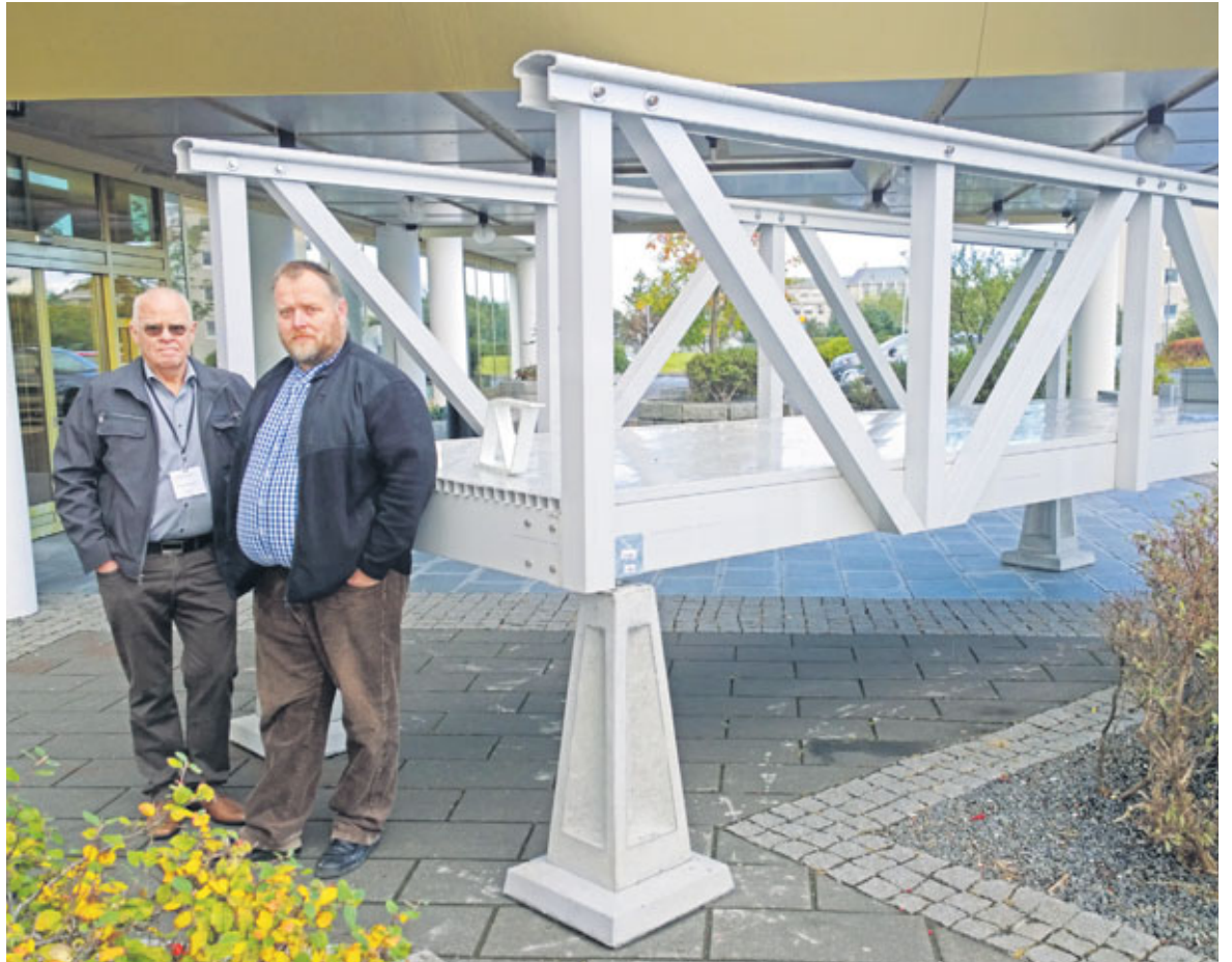
Ragnar Kærnested hjá Gný og Þórarinn Sighvatsson hjá Stykki við brú úr FRP-efni sem kynnt var á brúarráðstefnu Norræna vegasambandsins (NVF) sem haldin var á Hótel Sögu fyrir skömmu. Þess má geta að brúin stendur þarna á svokölluðum Dvergum sem eru undirstöðustólpur sem Íslandshús hefur verið að markaðssetja. Myndir / HKr.
