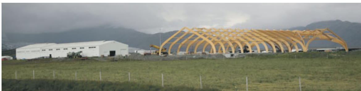
Nýja fjósið í Flatey er engin smásmíði og minnir helst á íþróttahöll. Við hlið þess er gamla fjósið sem áður var grasköggglaverksmiðja.
