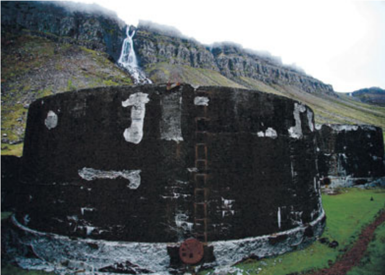
Lýsistankarnir við síldarverksmiðjuna í Djúpavík.
