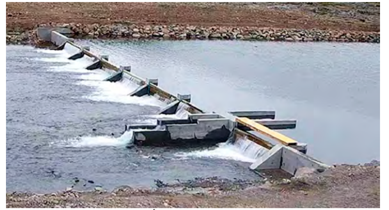
Fyrirstöðuprep í Langadalsá í Ísafjarðardjúpi. Teljarinn er staðsettur í hólfinu ofan við þrepið. Mynd / Hafrannsóknastofnun.
