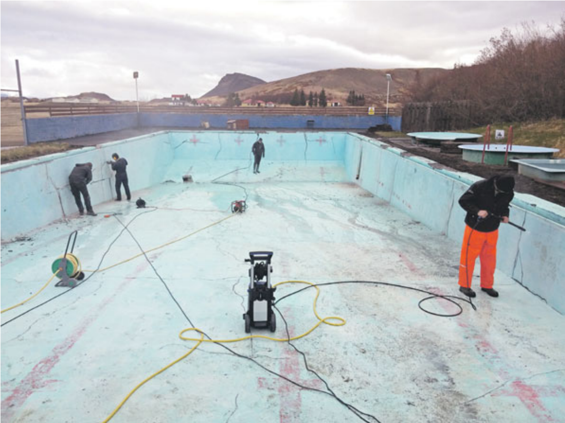
Framkvæmdir í Hreppslaug vorið 2016.
