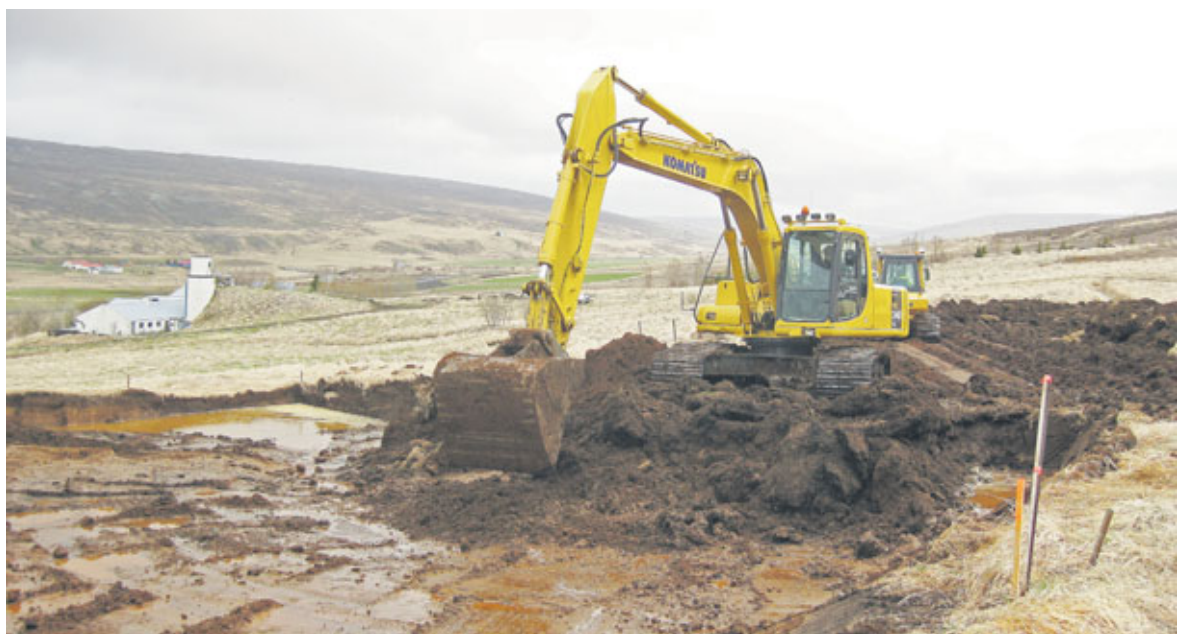
Jarðvegsvinna fyrir Norðurljósarannsóknamiðstöð Aurora Observatory (AO), sem rísa mun á Kárhóli í Reykjadal, er hafin.
