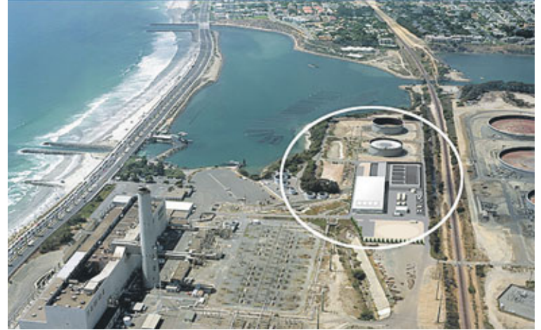
Í Carlsbad í Kaliforníu er verið að reisa stærstu hreinsunarstöð á Vesturlöndum sem á að breyta sjó í drykkjarvatn í gegnum filtera í svokölluðu „reverse osmosis“-kerfi. Er ætlanin að stöðin verði komin í fullan rekstur á næsta ári, 2016. Mynd / Desalination Project
