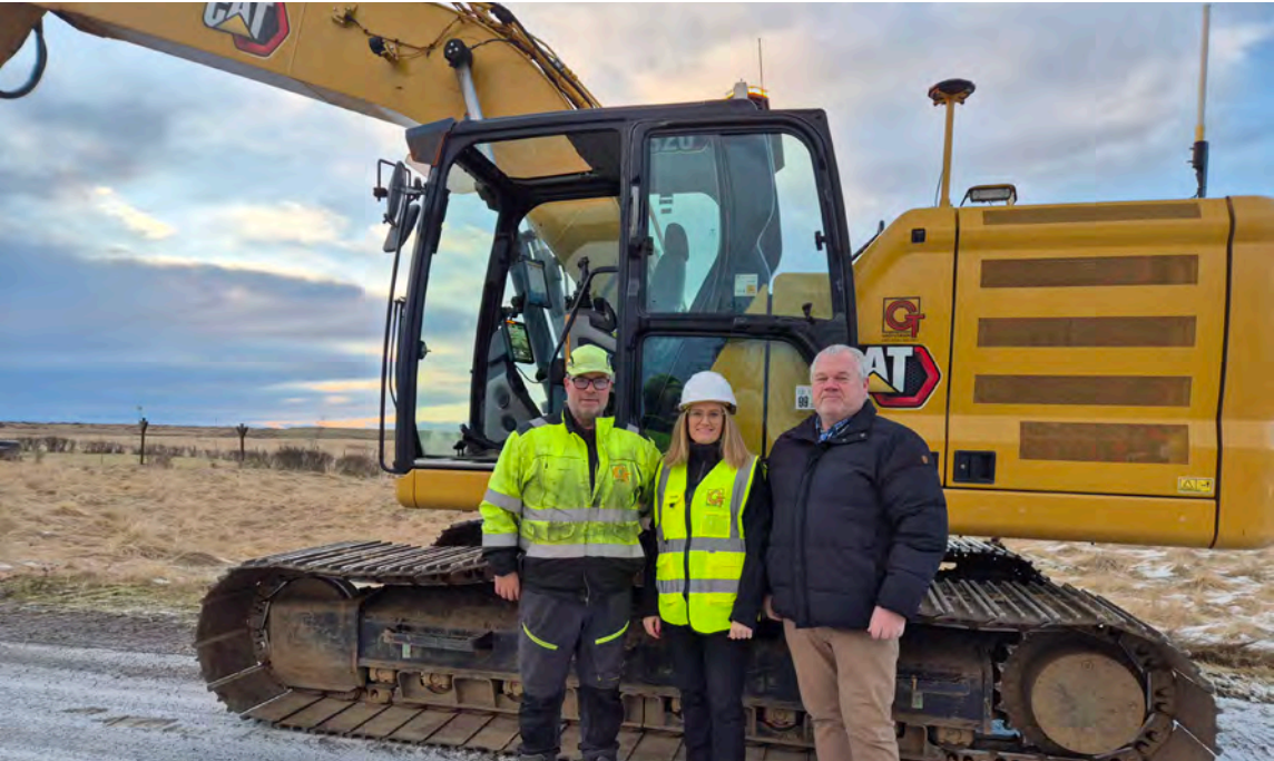
Sveitarstjóri Flóahrepps vippaði sér upp í gröfuna og tók fyrstu skóflustunguna að nýja hverfinu við Þingborg. Mynd / Aðsend
