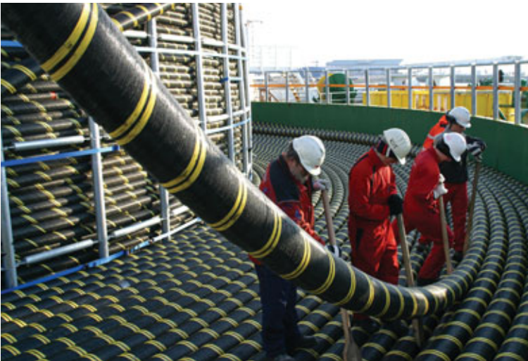
Sæstreng komið fyrir um borð í lagningsskipi.
