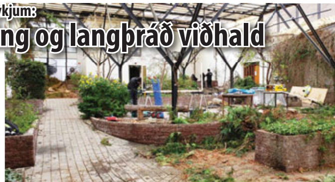
Framkvæmdum við endurbyggingu gróðurskálans Garðyrkjuskólans miðar vel.
